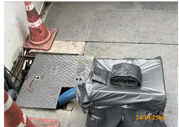
รูปที่ 2-10 การสูบน้ำตะกอน
